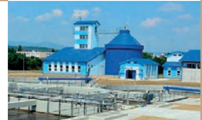
Kläranlage Nové Mesto nad Váhom, Slowakei
