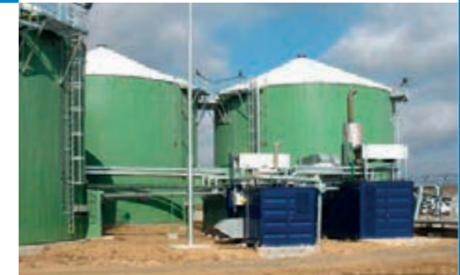
Biogasanlage, Hostouň, Tschechische Republik
