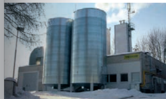
Fernwärme, Světlá n. Sázavou, Česká republika
